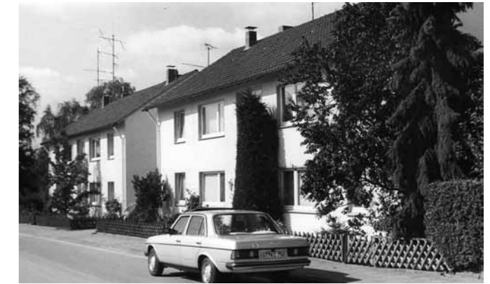
8 Wohnungen Mönchstr. 52 + 54, Halle (Westf.), Fertigstellung 1959
