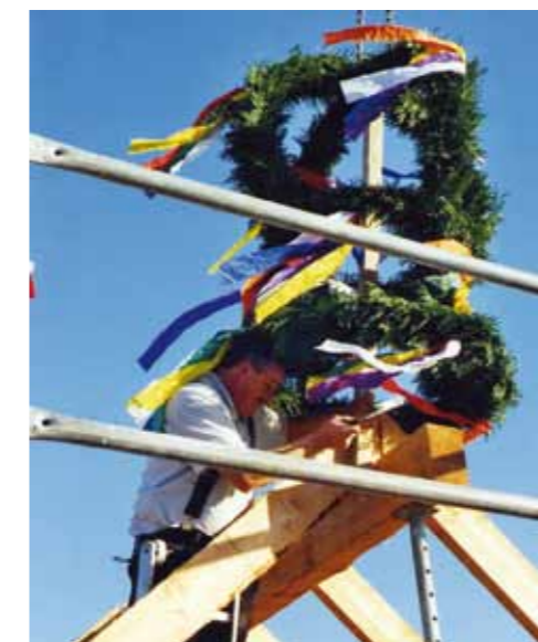
Der Zimmermann schmückt den Bau mit dem Richtkranz.
