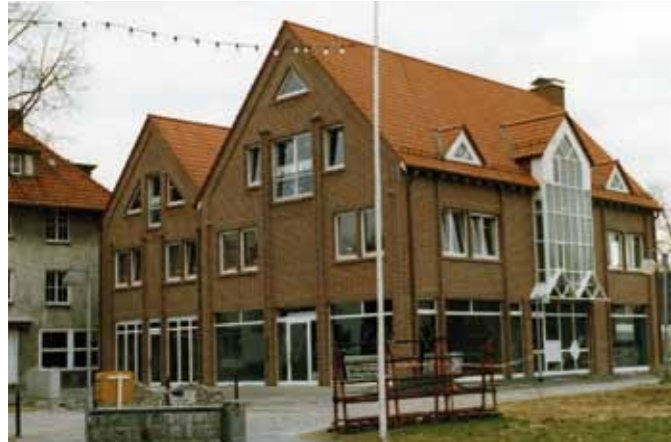
Büro- und Geschäftshaus Ronchinplatz 1, Halle (Westf.), 1987
