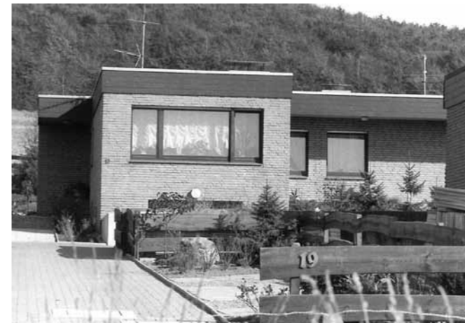
Eigenheim Elsa-Brandström-Straße, Halle (Westf.)
