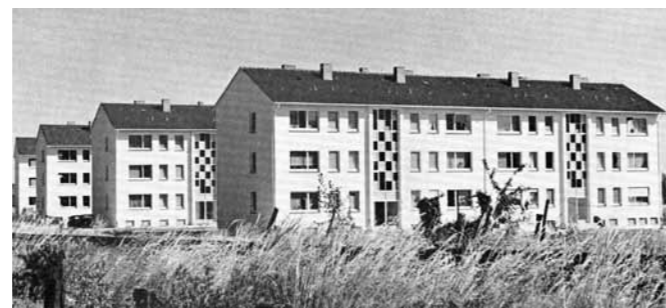
Siedlung Hartmanns Wäldchen, Halle (Westf.) Fertigstellung 1959.
