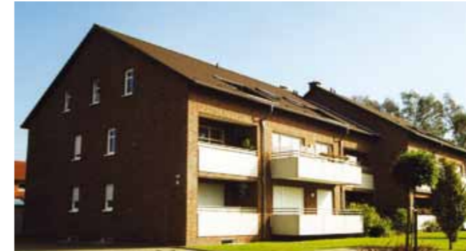
12 Wohnungen Akazienweg 5 + 7, Halle (Westf.), Fertigstellung 1991
